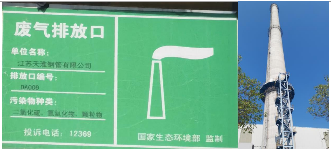
DA009 环形加热炉废气排放口
